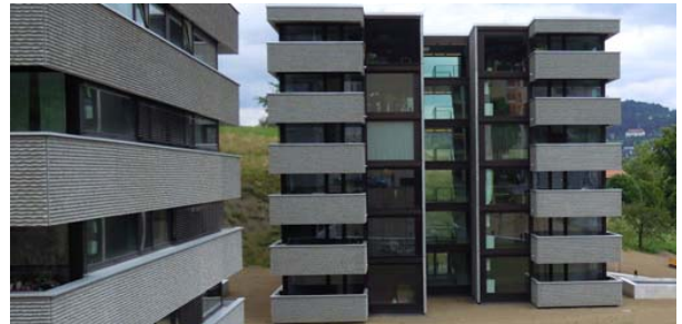
Wohnüberbauung Vorderrain, Luzern
